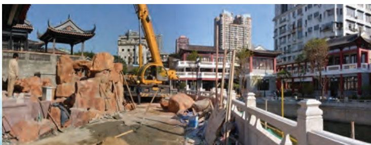
荔枝灣涌改造期間一段施工中的新河堤。此段現為廣州粵劇藝術博物館
