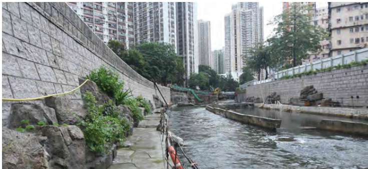
啓德明渠改造後成為啓德河，在施工的後期開始加入更多的園景及綠化元素
